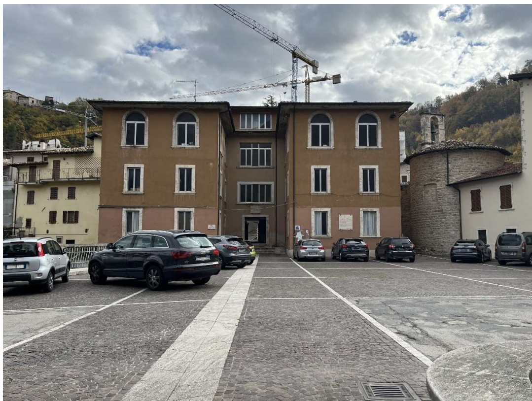
Sede del Municipio in ristrutturazione/COC – Piazza XX Settembre
