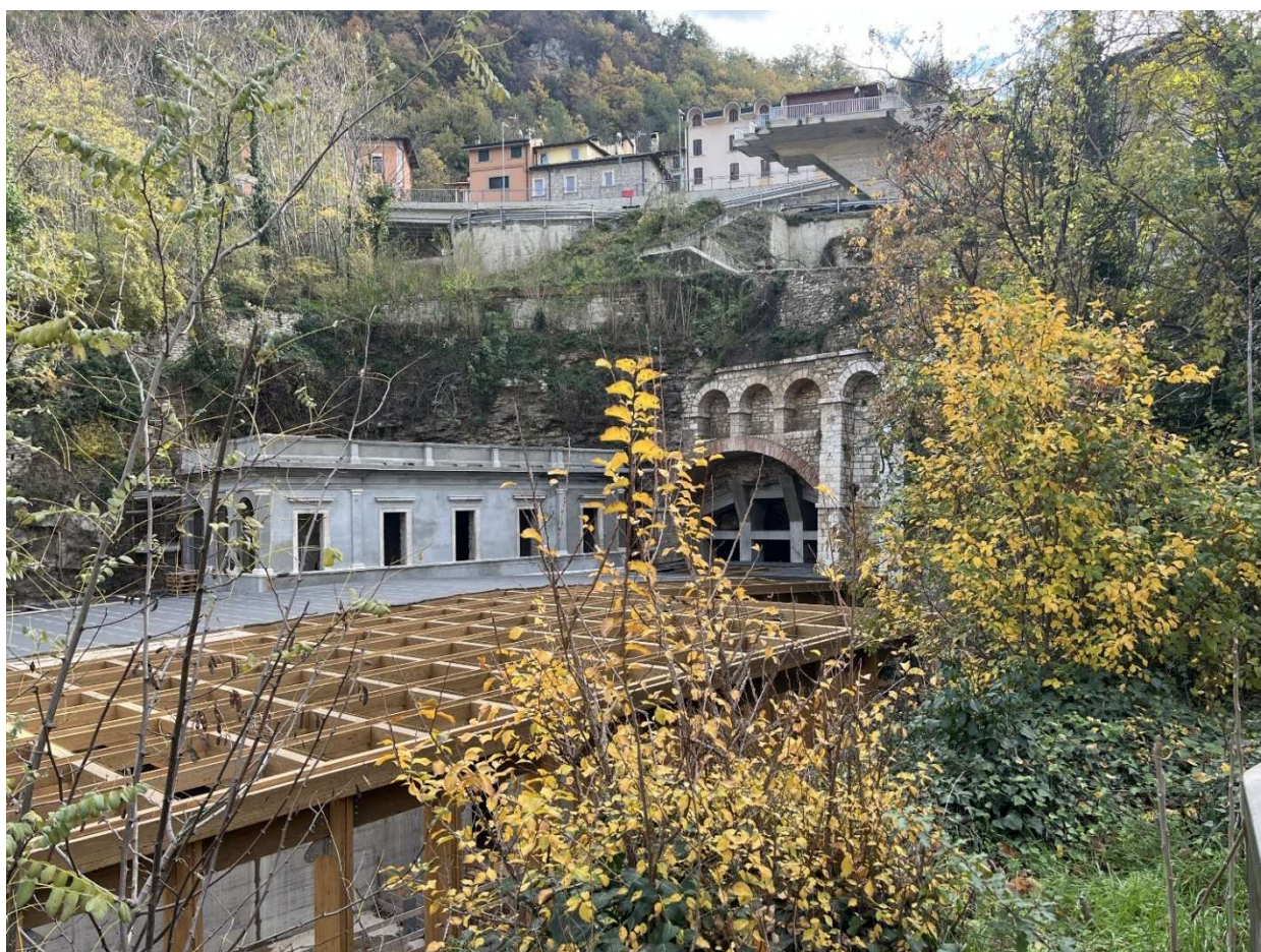
Vista dell'area sotto la SS4 Salaria interessata dalla criticità per cavità sotterranee.
